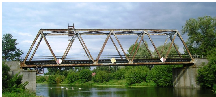
Rysunek 4.1. Widok kratownicowego mostu kolejowego w Nieporęcie koło Warszawy.
