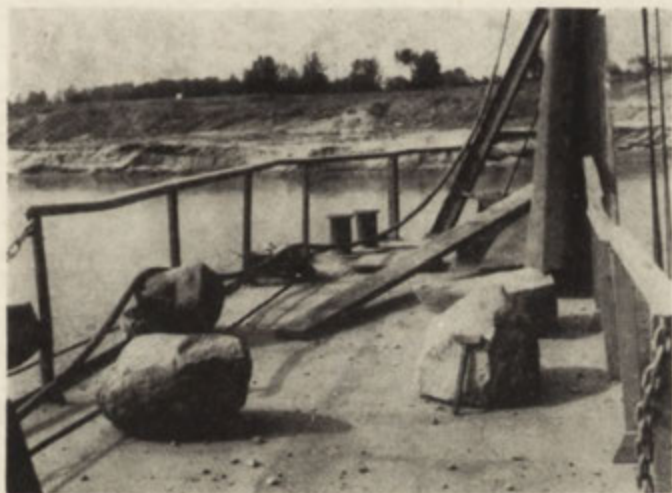
Ryc. 6. Głazy narzutowe wydobyte przez koparkę z koryta Dunajca w Komorowie Buried rock bloks removed by digging from the Dunajec chaunel of Komorów
