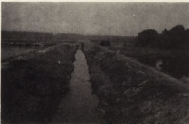
Fot. 6. Przykład regulacji cieków zdeformowanych wskutek ruchów powierzchni ziemi Example of adjustment of creek channel deformed by ground movements
