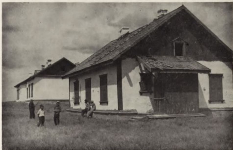
Fot. 4. Budynki obecnej stacji naukowej mongolsko-polskiej założonej w czerwcu 1975 r. koło Bajan (zdjęcie wykonane przed remontem)
