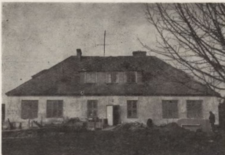
Fot. 1. Budynek Stacji w czasie prac remontowych The Station building during redevelopment
