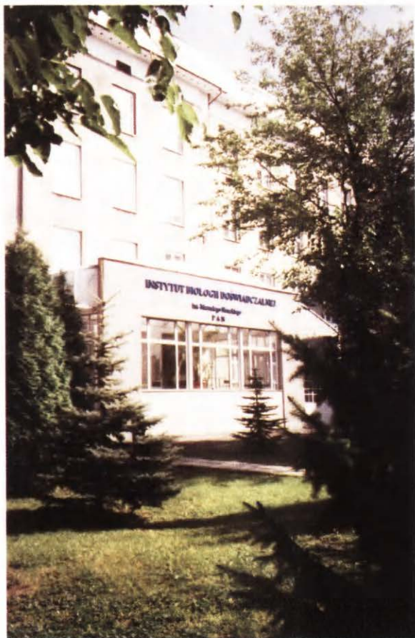
Wejście do głównego budynku Instytutu Nenckiego. Stan obecny.
