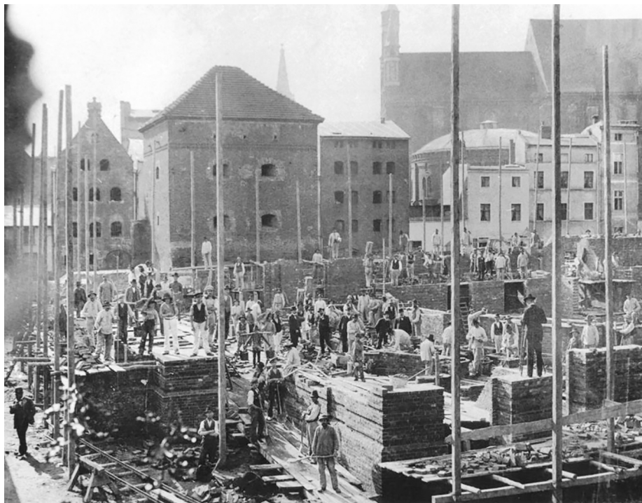
7. Teatr Miejski w trakcie budowy – fotografia wykonana latem 1903 r.; Książnica Miejska w Toruniu, Dział Zbiorów Specjalnych. Grafika, t. 5, nr 33.
