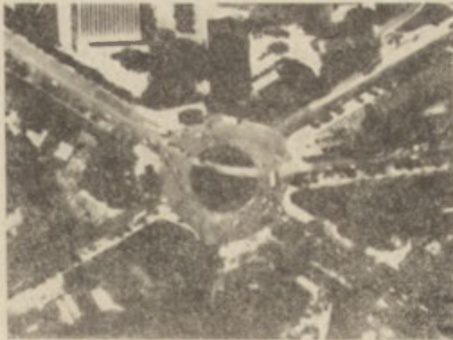
Fot. 2. Zdjęcie lotnicze placu Unii Lubelskiej wykonane 16 czerwca 1966 r. o godz. 12,06
