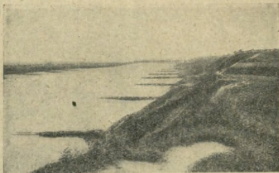
Fig. 15 Dolina Wisły pod Grudziądzem. Koryto Wisły jest opatrzone poprzecznymi tamami
