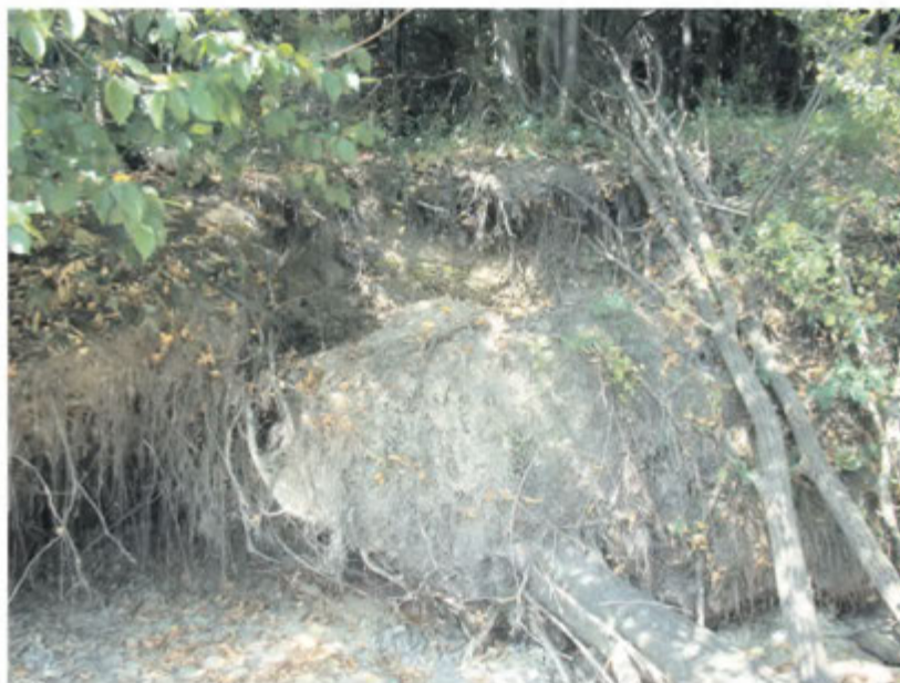
Fot. 6. Powalone drzewa wraz z systemem korzeniowym powodujące rozwój klifu na zbiorniku „Klimkówka”
