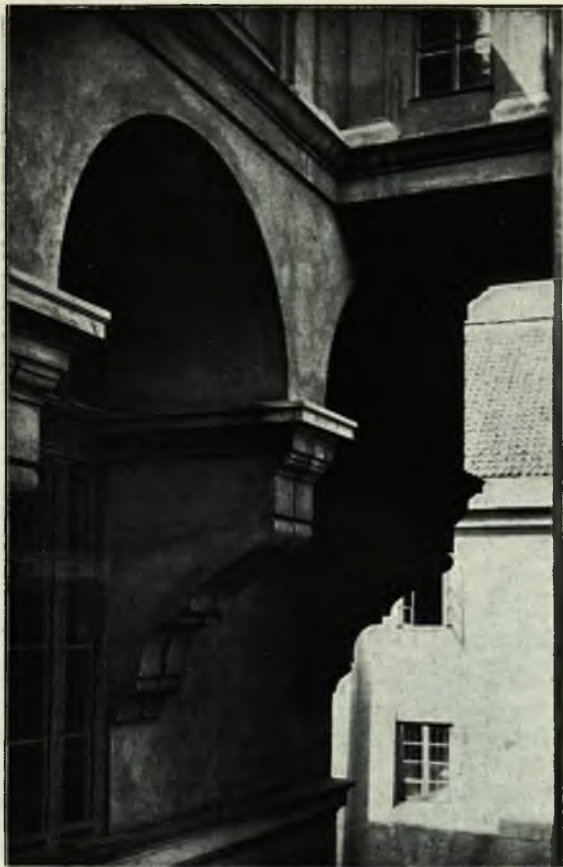
Przejście wykuszowe do budynku gospodarczego
