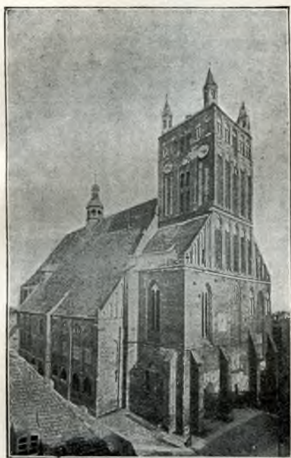
Fig. 1. Stettin; Jakobikirche vor der Wiederherstellung; von Nordwesten gesehen.
