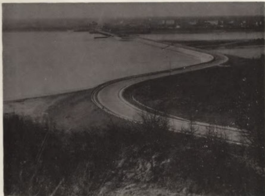
Fot. 1. Zapora na Wiśle we Włocławku (Fot. M. Banach) Dam on the Vistula river in Włocławek (Phot. by M. Banach)
