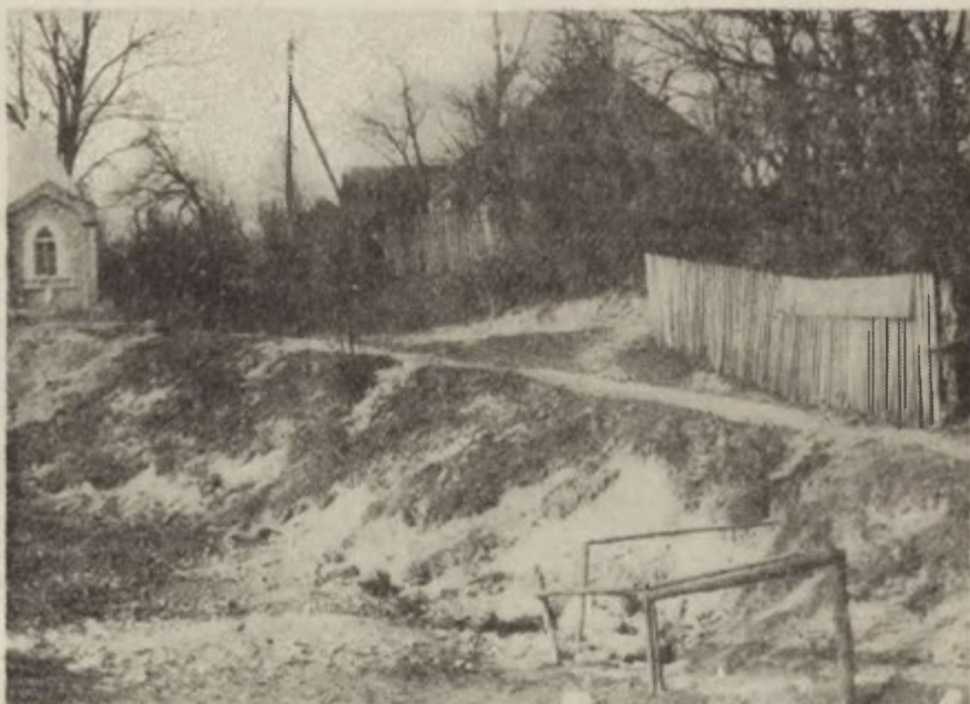
Fot. 2. Nisza źródliskowa w okresie całkowitego zaniku wypływu źródeł Stanianki (fot. 12 IV 1974 r.) The alcove during a complete disappearance of the outflows from the Stanianka source (photographed on 12 April 1974)
