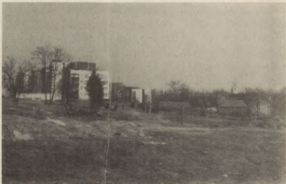
Fot. 1. Rozległe obszary niezagospodarowane bardzo często sąsiadują z nowymi osiedlami mieszkaniowymi (Warszawa, Służew nad Dolinką). Fot. Agata Niedek Vast unorganized areas very frequently neighbour on new housing developments (Warsaw, Służew nad Dolinką housing development). Phot. by Agata Niedek
