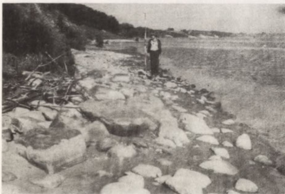
Fot. 8. Abrazyjna część platformy przybrzeżnej zbiornika w rejonie Dobrzynia. Głazy stanowią rezyduum z rozmycia utworów czwartorzędowych. Stan wód zbiornika niski 17 sierpnia 1980
