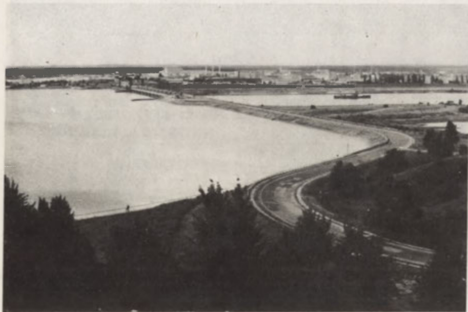
Fot. 1. Stopień wodny na Wiśle we Włocławku, eksploatowany od 1969 r. (23 VI 1986 r.)
