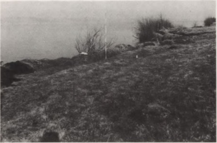
Fot. 5. Abrazyjny brzeg zapory bocznej w Modzerowie spiętrzony w formie wału przez napór pokrywy lodowej (15 IV 1986 r.) Abrasive bank of side dam in Modzerewo hummocked in the form of embankment by the pressure of ice cover (15 April 1986)
