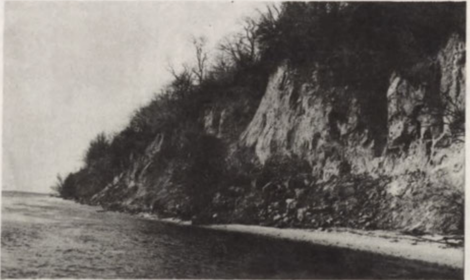
Fot. 3. Gлина zwałowa z przemazami piaszczystymi w czynnym obecnie klifowym brzegu w Maszewie. Wysokość klifu, będącego koluwium starego, nieczynnego osuwiska, wynosi około 12 m (14 VI 1982 r.) Boulder clay with interbedded sand in the currently active cliff bank in Maszewo. The height of cliff which is a colluvium of an old inactive earthslide is some 12 m (14 June 1982)
