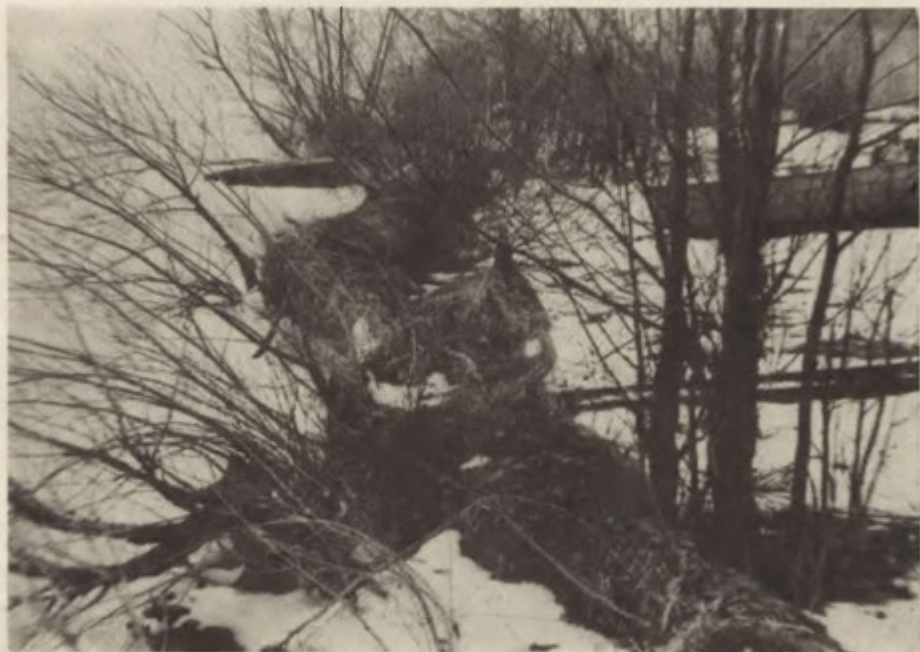
Fot. 3. Stary wał brzegowy typu fałdowego z cechami świeżych deformacji (fot. P. Gierszewski ) An old fold-type dyke with a trace of new deformation (photo: P. Gierszewski )
