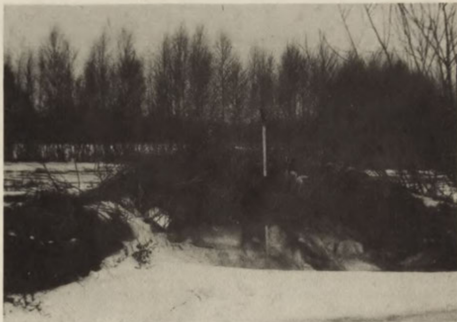
Fot. 2. Wał brzegowy typu faldowego (fot. P. Gierszewski ) A fold-type dyke (photo: P. Gierszewski )
