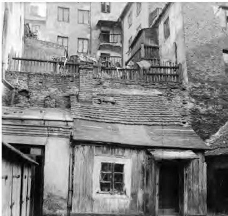
V. Podwórze warszawskie przed 1914 r., fot. Z. Marcinkowski. Na zdjęciu świetnie widać różnice w zabudowie sąsiadujących podwórek. Ponad drewnianymi domkami mieszkalnymi piętrzą się oficyny sąsiedniej kamienicy o zróżnicowanej wysokości. Widoczne na zdjęciach zabudowania drewniane przykuwały uwagę fotografów.
