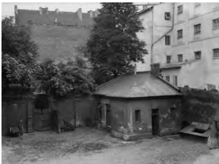
VI. Podwórze warszawskie przed 1914 r., fot. Z. Marcinkowski. Tylna część posesji z niewysokim murkiem oddzielającym je od sąsiedniego domu (widoczne okna oficyny). Zwraca uwagę nieduży domek – być może mieszkanie stróża – oraz pojemnik na śmieci po prawej. W głębi widać zieleni sadu, do którego dostęp możliwy był poprzez drewnianą furtkę w murze.
