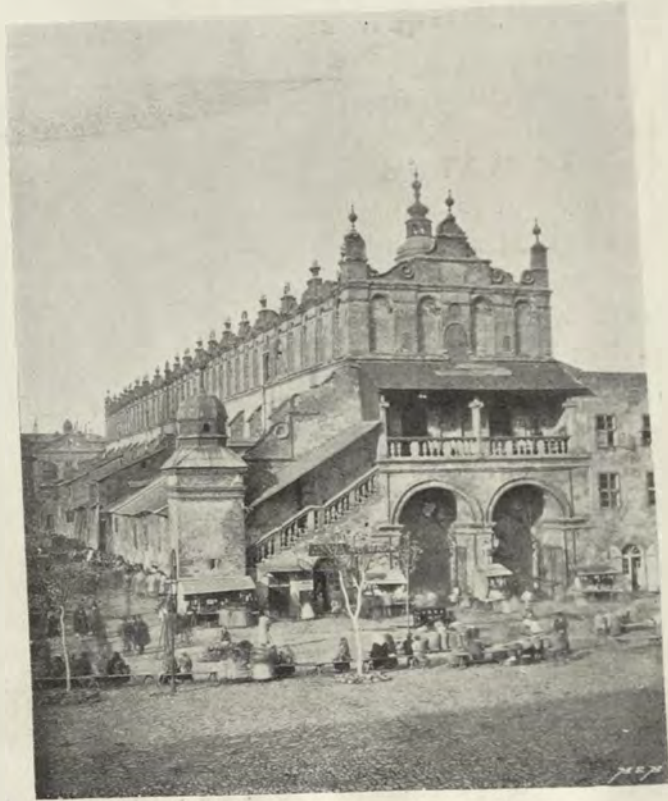
Les Sukiennice avant la restauration.
