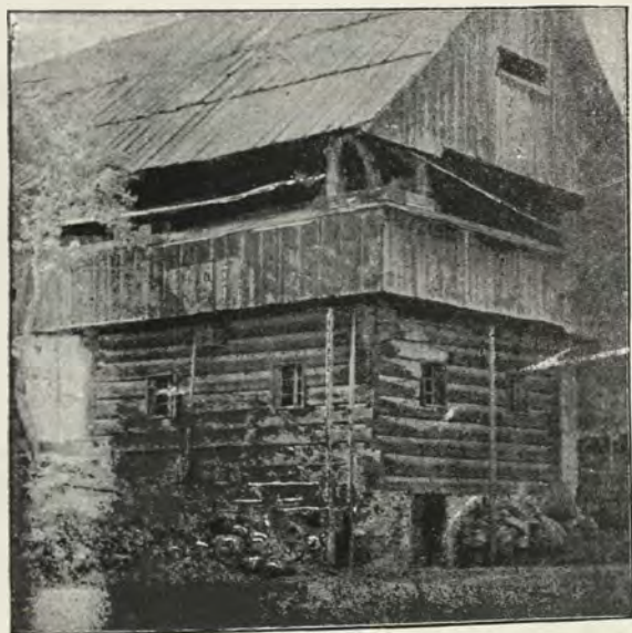
Рис. 76. Двухэтажная хиша словинца изъ дер. Нижняя Гарья, выстроенная въ 1748 г. и перестроенная въ 1858 г. (Съ фот. автора).
