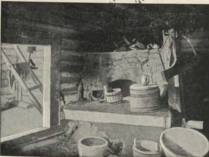
Рис. 169. Глинобитная печь съ черной топкой изъ дер. Адамовичи Вилейскаго уѣзда, Виленской губ. (Съ фот. П. Н. Сергіевскаго).
