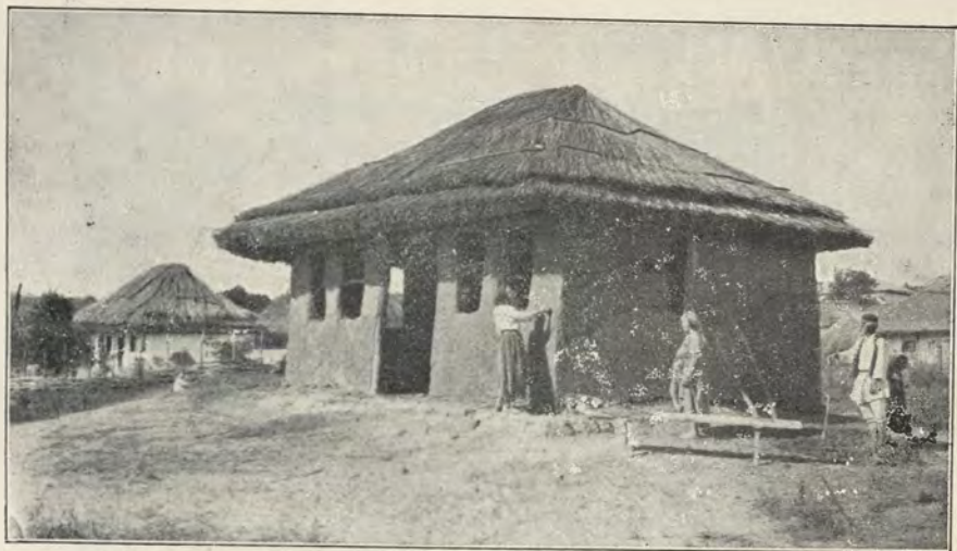
Рис. 181. Х а т а ( каса ) изъ Бессарабской г уб. Обмазка плетеняго остова глиной (Съ фот. Д. Сумовскаго).
