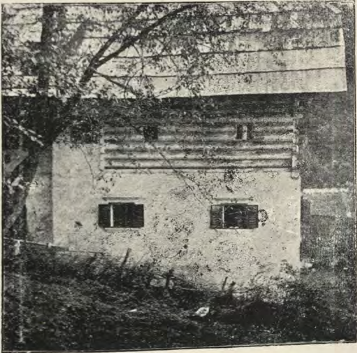
Рис. 81. Словинскій каменный домъ съ деревян- ной горней хишей изъ дер. Кропа въ Краинѣ. (Съ фот. автора)
