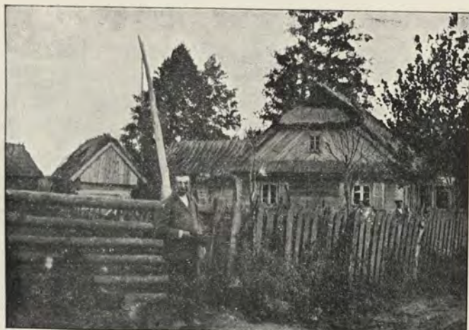
Рис. 6. Хата крестьянина изъ околицы Бѣлосукно Бѣлостокскаго уѣзда, Гродненской губерніи. (Съ фот. Н. Г. Невѣровича).
