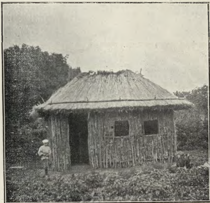
Рис. 189. Остовъ хаты (кассы) , обмазанный изнутри глиной изъ с. Кугурешты Сорок- скаго у. Бессарабской губ. (Съ фот. автора).
