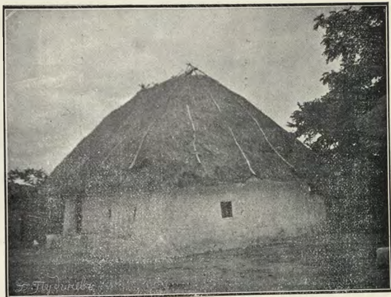
Рис. 190. Столѣтная хата (каса) изъ с. Нападово Сорокскаго у. Бессарабской губ. (Съ фот. автора).
