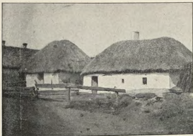
Рис. 162. Хата съ будной изъ дер. Алексѣевки Верхнеднѣпровскаго уѣзда, Екатеринославской губерніи. (Съ фот. автора).
