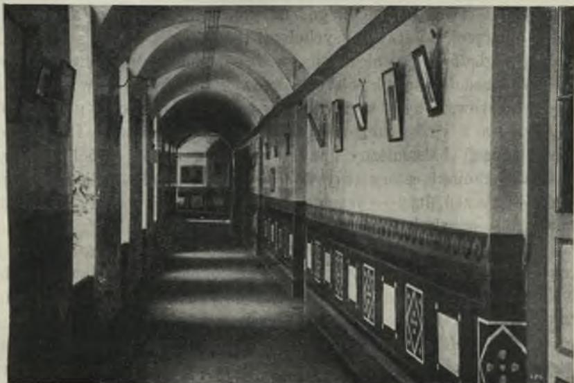
Korytarz pierwszego piętra.
