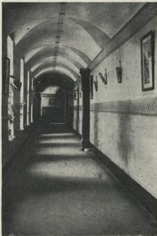
Korytarz drugiego piętra.
