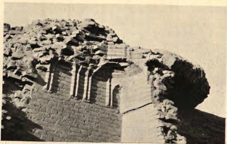
FIG. 134.—KHÂN KHERÎNA, SETTING OF DOME.
