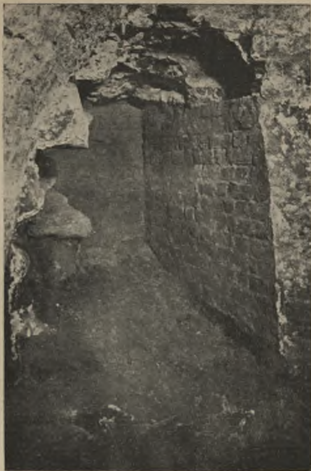
Zamek królewski w Warszawie. Epoka ks. Mazowieckich. Mur piwnicy pod salą o 2 słupach od strony Baszty Grodzkiej.
