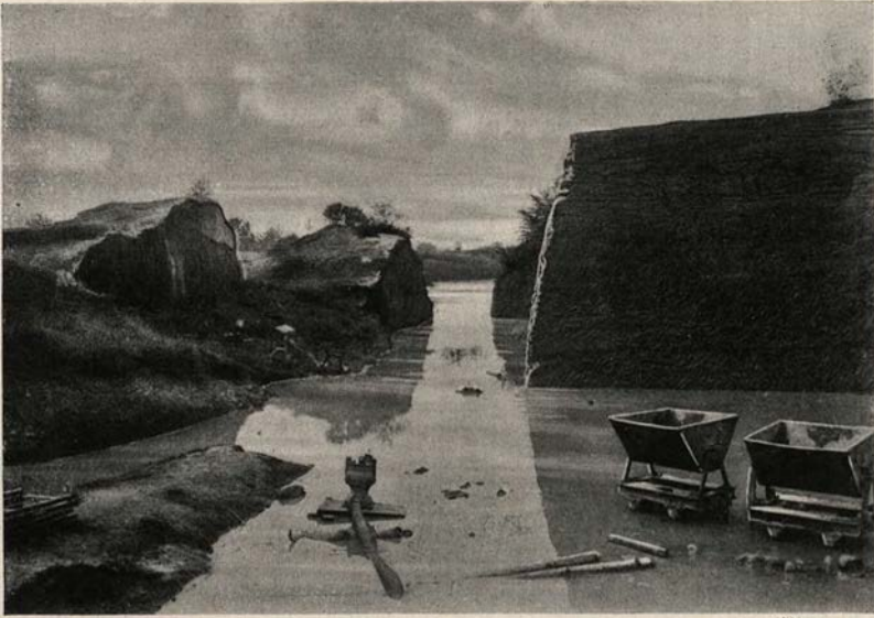
Hochwasser am 4. November 1908 in Grube I. (Phot. von Dozy.)
