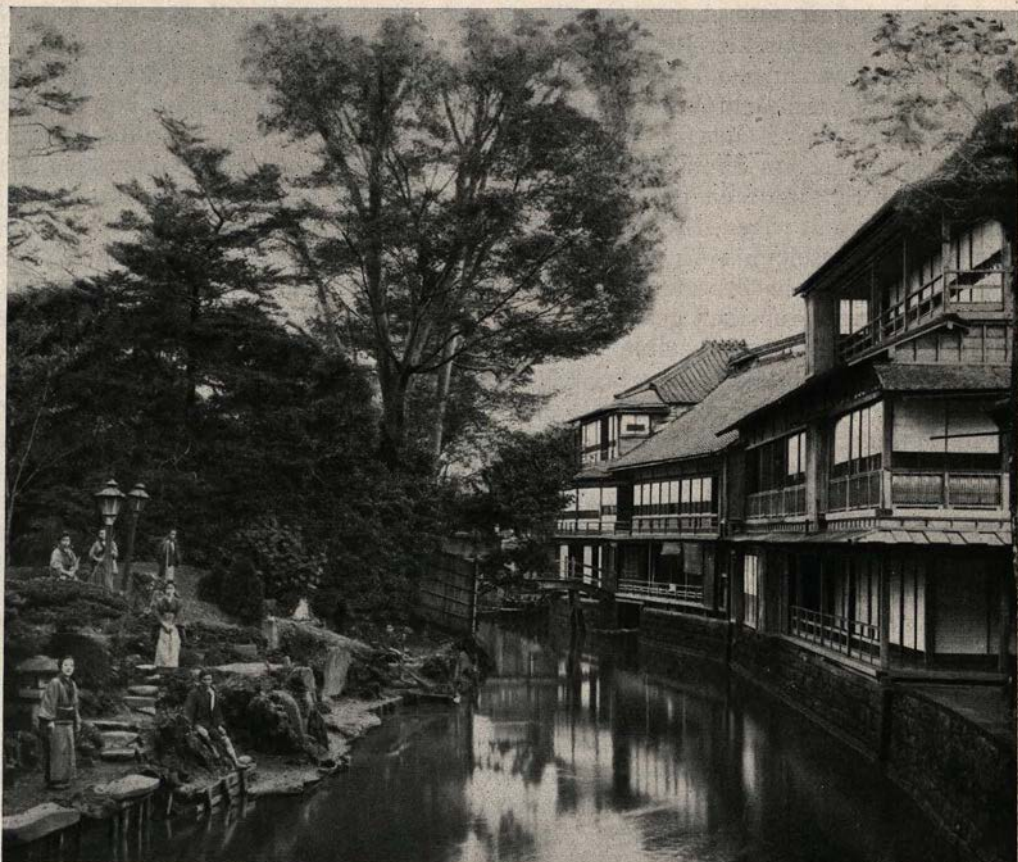
Teehaus in Oji (bei Tokyo).
