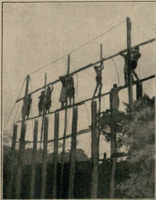
Errichtung eines Dachstuhles.
