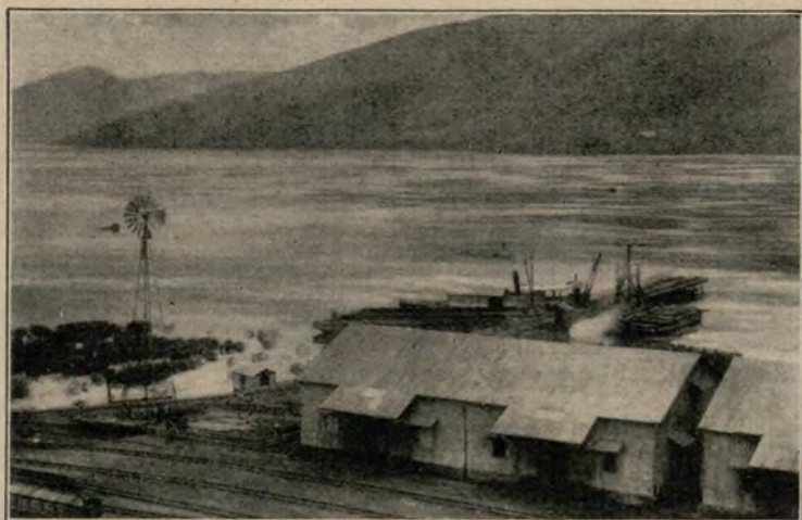
Landungsbrücke und Eisenbahn von Matadi.
