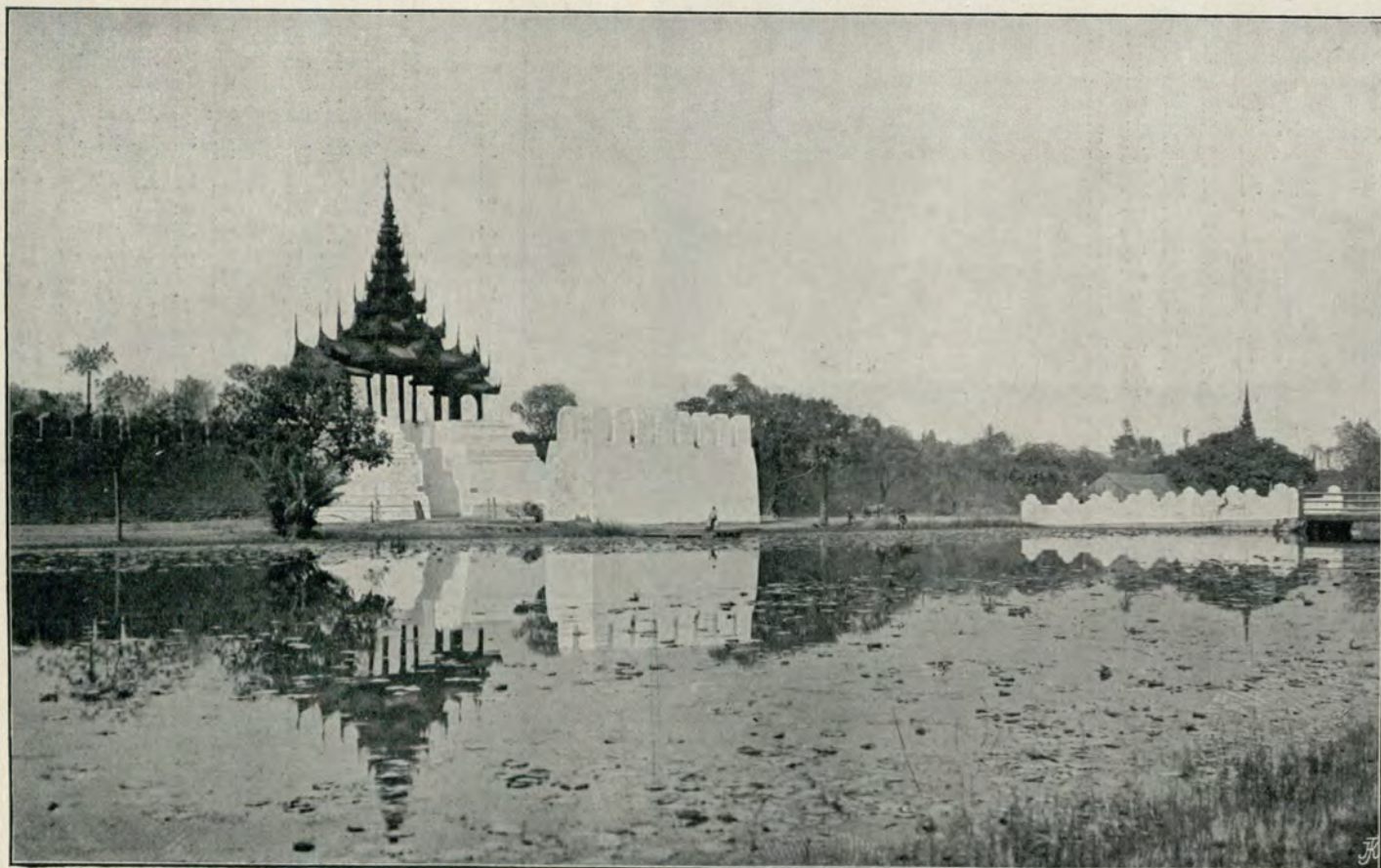
Abb. 96. Arrakanpagode — Stadtmauer von Mandalay.
