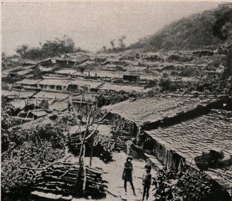
20. Paiwandorf; die Häuser sind aus Schiefer gebaut und mehr als wandhoch in den gewachsenen Boden eingesenkt
