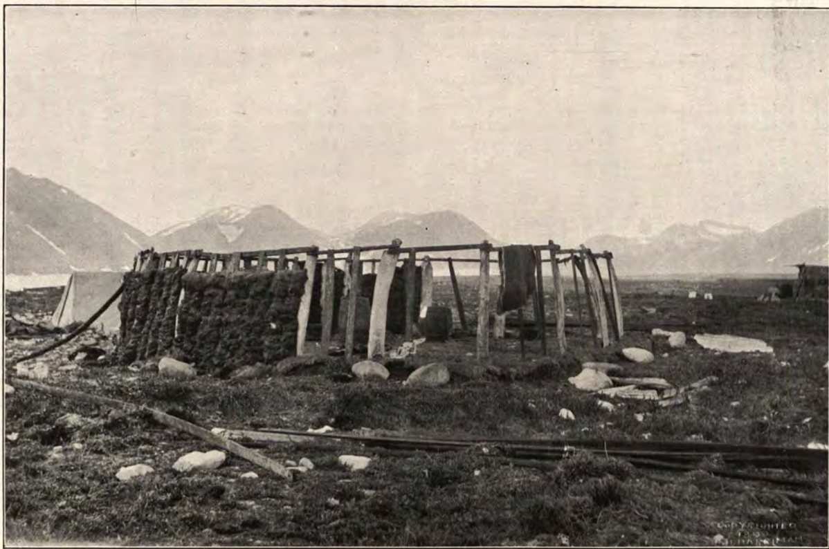
Im Bau begriffenes Eskimohaus, Winterwohnung.
