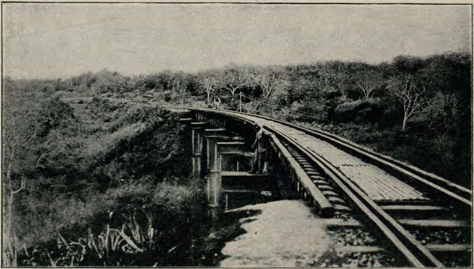
Viadukt der Uganda-Bahn. (Figuera, Mombasa.)
