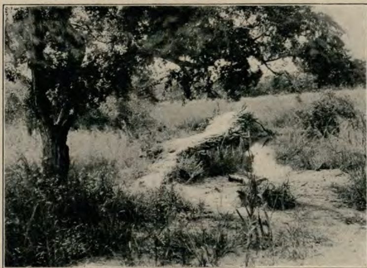
Brücke über den Getti.
