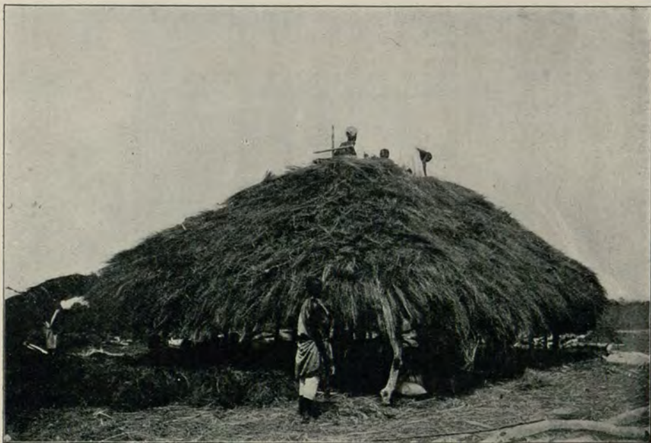
Bau der Kapellenhütte in Omadsch.
