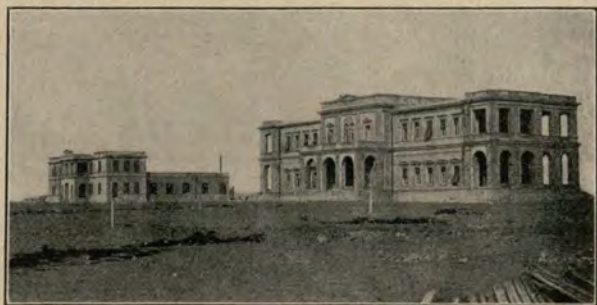
Neubauten der Post und des Gouvernorates in Port Sudan.
