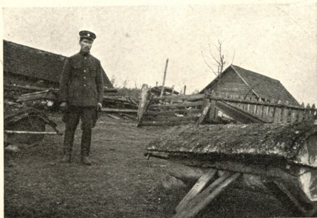
Ryc. 47. Leżaki żmudzkie z charakterystycznymi daszkami z kory brzoowej, naciągniętej na drewniane pałaki. Leśniczówka Laukagalis, pow. uściański (Litwa Kowieńska).
