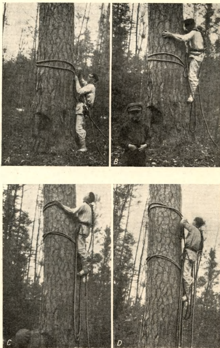
Ryc. 16 A—D. Sposób dostawania się do barci przy pomocy leziwa. Gajowy Benedykt Bura. Zapurwie, pow. grodzieński: A—Przekładanie strzemia. B—Wstępowanie w strzemię. C—Pachanie podwójnie złożonego uzyska. D—Przekładanie następnego strzemia.
