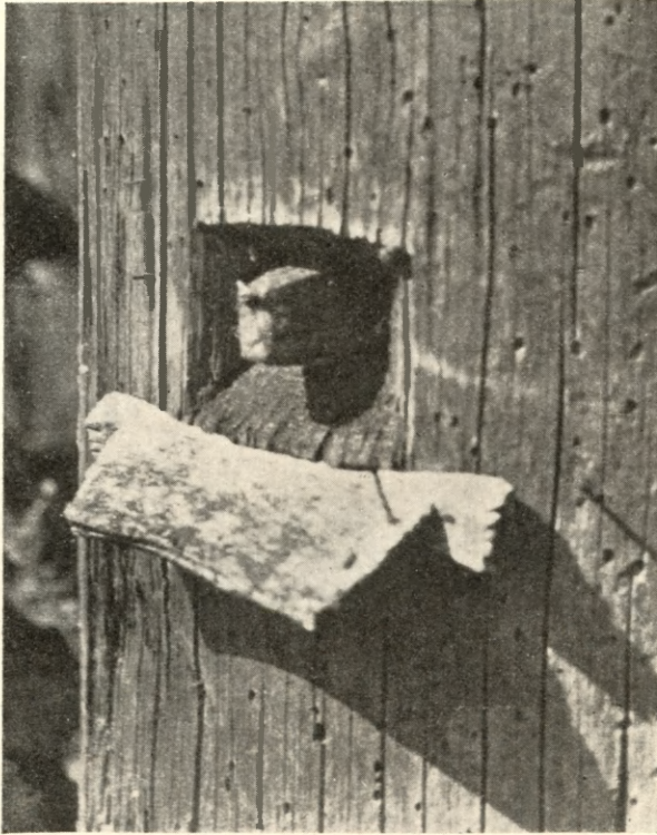
Ryc. 33. Oko kłody-stojaka z wystającym oczkasem i siodełkiem. Biszczka, pow. biłgorajski.
