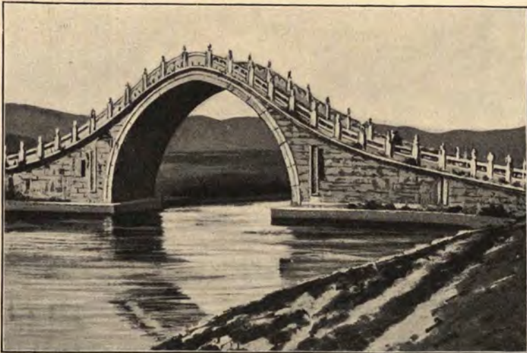
Kamelbrücken-Brücke bei Pe King.
