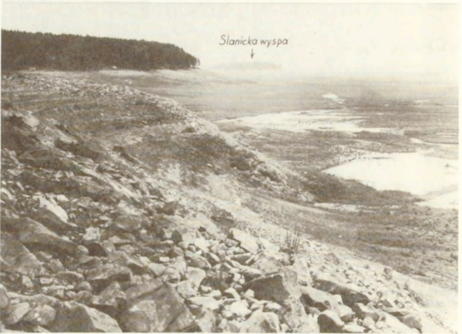
Fot. 1. Misa zbiornika w sąsiedztwie hotelu „Goral”. Widoczny z lewej strony narzut kamienny w strefie brzegowej chroni ją przed abrazją falową. 2 VII 1990 r.
