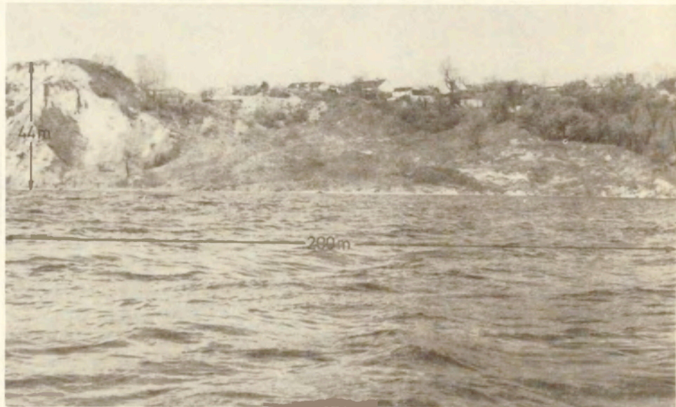
Fot. 1. Osuwiskowe zbocze w Dobrzyniu przy ul. Podzamcze, stale czynne, zagrażające zwartej zabudowie miasta. Miąższość koluwiów w środkowej części formy do 10 m (3 IV 1990 r.) Landslide slope in Dobrzyń (Podzamcze street), constantly active, being imminent for the compact settlement of the city. A thickness of colluvia in the middle part of the form up to 10 m
