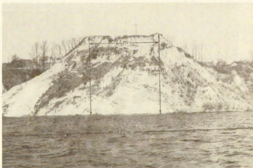
Fot. 2. Południowa ściana Góry Zamkowej w Dobrzyniu — cypel wysoczyzny morenowej. W profilu zbocza brak ilastych utworów. Średni kąt nachylenia zbocza wynosi 45°, a odległość krzyża od krawędzi 19,3 m — pomiar z 8 VIII 1991 r. (3 IV 1990 r.) South wall of Zamkowa Góra in Dobrzyń — the morainic plateau cusp. In the slope profile clay formations are lacking. A mean angle of inclination amounts 45°, and the distance between the cross and the edge — 19,3 m, measured in 8 August, 1991
