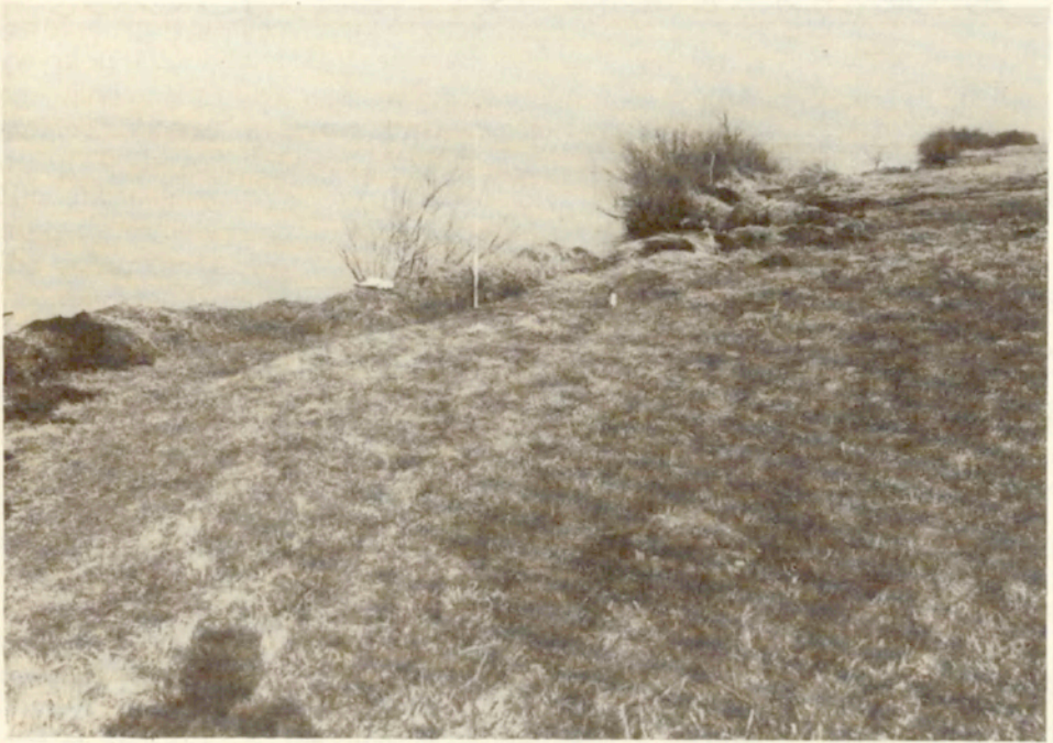
Fot. 5. Abrazyjny brzeg zapory bocznej w Modzerowie, spiętrzony w formie wału na skutek naporu pokrywy lodowej (15 IV 1986 r.)
