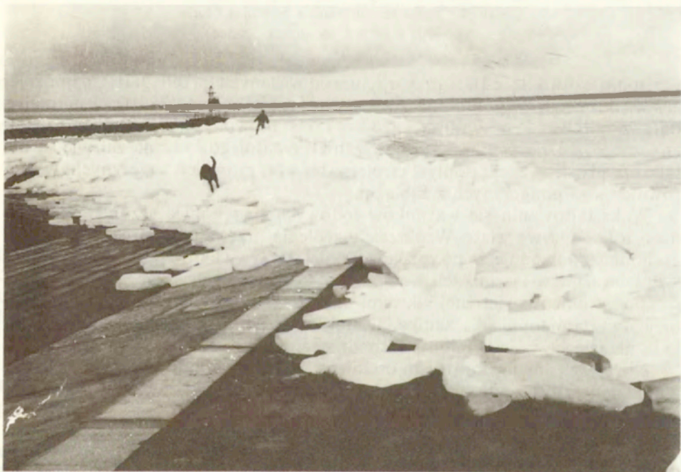
Fot. 4. Nasunięte i spiętrzone od czoła pole lodowe na umocnieniach brzegowych w rejonie portu rybackiego (Tolkmicko, 30 XII 1992) Rafted and hummocked ice field on shore strengthening structures near the fishing harbour (Tolkmicko, 30 Dec. 1992)
