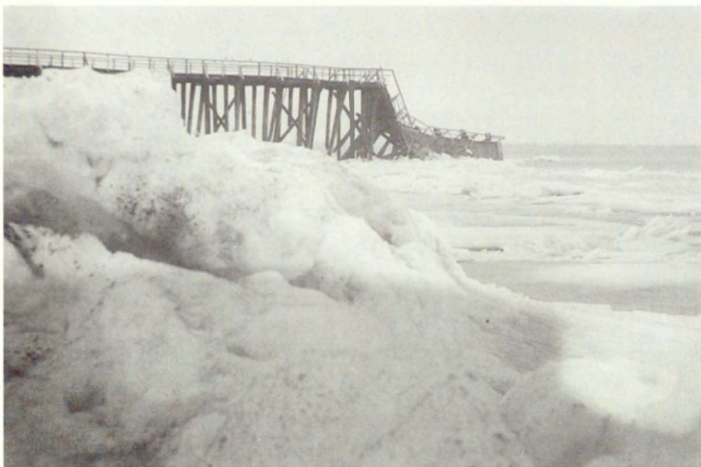
Fot. 2. Zniszczone molo w Międzyzdrojach przez napierającą krę lodową (20 III 1985 r.) Destroyed pier by a pressing pack ice in Międzyzdroje (20 Mar. 1985)
