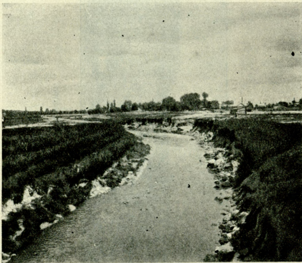
Ryc. 2. Erozja Pełtwi i niszczenie obmurowań regulacyjnych na Zamarstynowie.
